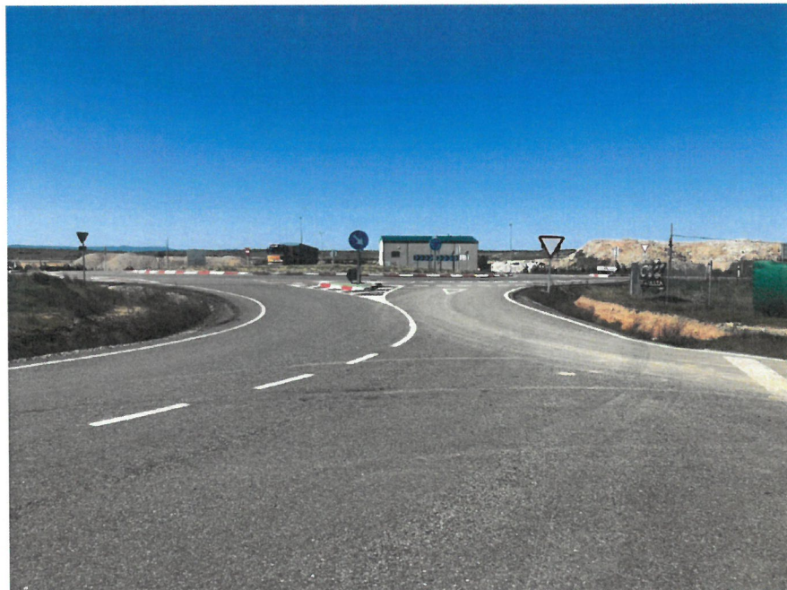
Planta de Rcd's más cercana, ubicada en la confluencia de la N-630 con la autovía.
