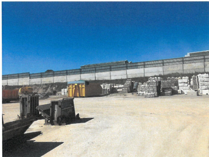
Cierre perimetral interno. Zona oeste
