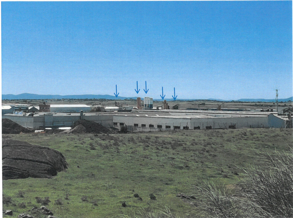
Polígono industrial de Cáceres, Las Capellanías. Instalaciones similares de varias empresas.
