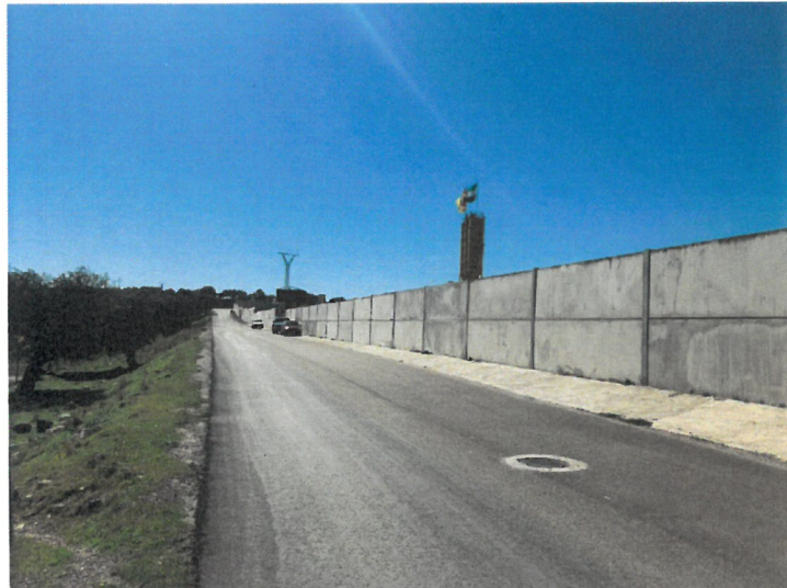
Cierre perimetral. Zona del Este de la parcela y entrada a instalaciones.
