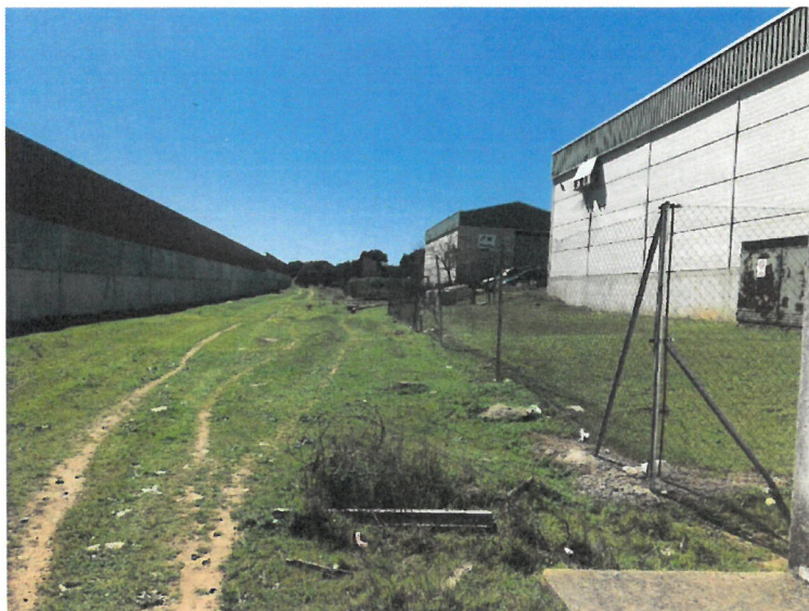
Cierre perimetral. Divisoria entre las instalaciones y naves del Semillero de empresas
