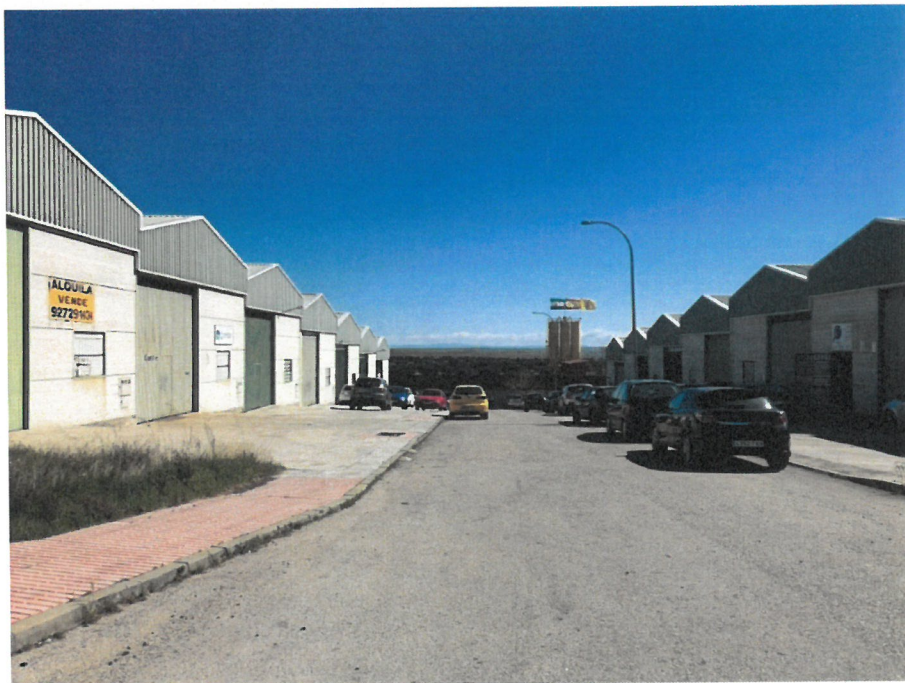
Naves del semillero. Al fondo silos de la planta de hormigón.
